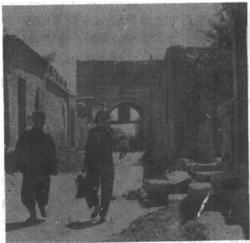
图3 河北省曲阳县灵山镇，图中的灵山阁顶已被日寇拆毁，修筑残杀我国人民的炮楼，1964年6月3日摄
